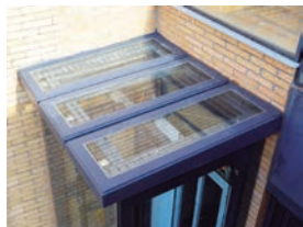
Dach (Blech oder Glas)
