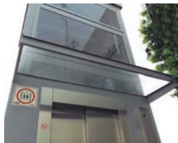
Türüberdachung (Blech oder Glas)
