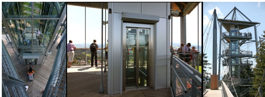
VFA Aufzug des Monats November ist der Skywalk in Scheidegg, gebaut von Berchtenbreiter aus Rieblingen Fotos honorarfrei: Berchtenbreiter
