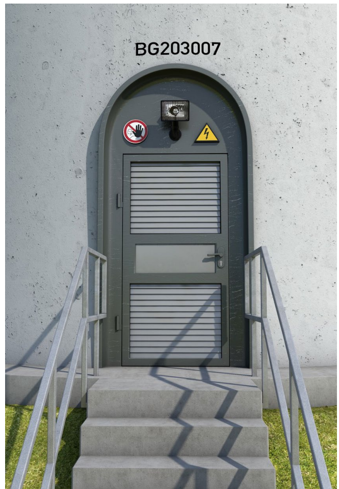
Abb. A13-7 Kennzeichnung WEA (Anlagennummer)
