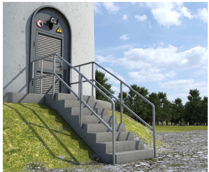
Abb. B1-1 Sicherer Zugang zur Anlage
