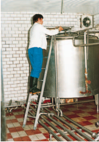
Bild 31: Leiter mit Einhängenvorrichtung am Behälter
