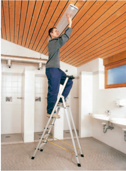
Bild 43: Sicherer Stand auf der Stehleiter mit Plattform
