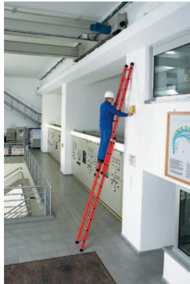
Bild 45: Sicherer Stand auf der Anlege-Schiebeleiter
