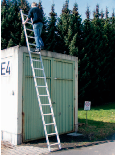
Bild 40: Übersteigen von der Anlegeleiter
