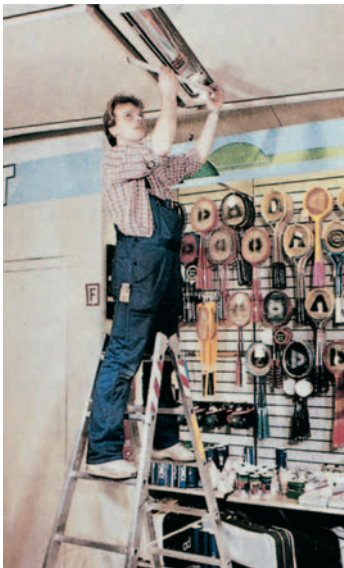
Bild 44: Sicherer Stand bei Über-Kopf-Arbeiten
